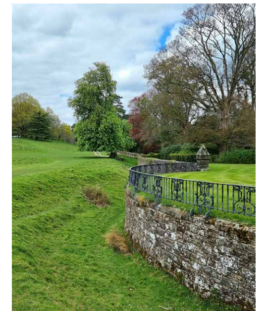
Ha-ha tuin in Petworth, west Sussex, Engeland. Duidelijk is te zien dat de formele tuin door een muur wordt gescheiden van het agrarisch landschap. De aansluitende diepe greppel moest het vee buitenhouden. Vanuit de tuin is die onzichtbaar, waardoor de illusie ontstaat dat, vanuit het huis gezien, de tuin uitloft in een continu landschap. Bron: Pixabay CL
