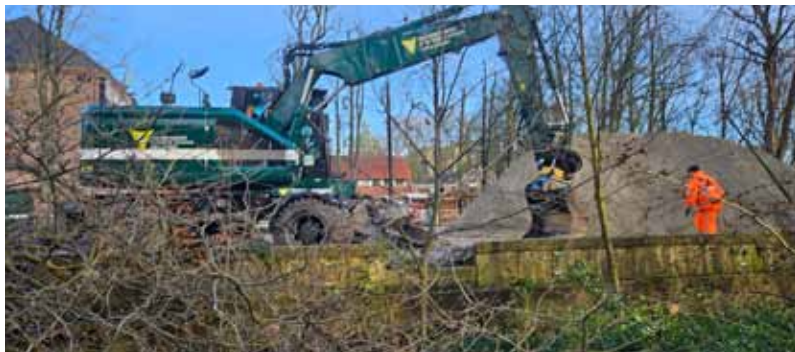
Het grote gaashek is weg. Nu de keerwand nog verwijderen.
