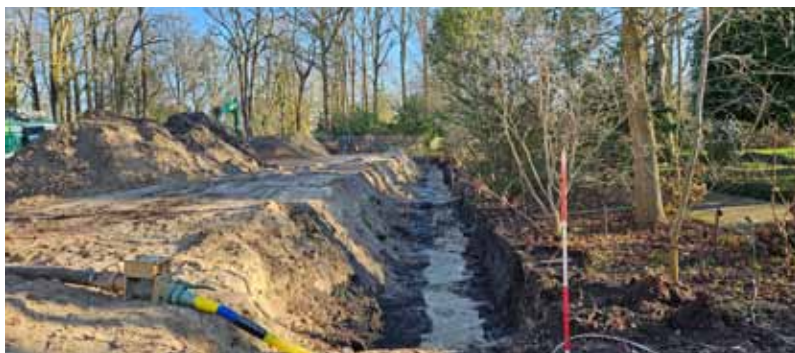
De lijn voor de nieuwe keerwand is uitgezet
