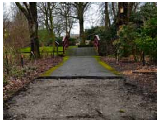
De eerste strook asfalt is verwijderd. Nog vele m2 te gaan.
