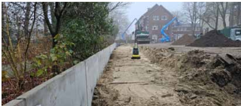
5. Keerwand is strak gezet.
